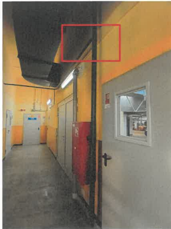
Zdjęcie 21. Punkt połączenia nowo budowanej instalacji z istniejącym odcinkiem.
