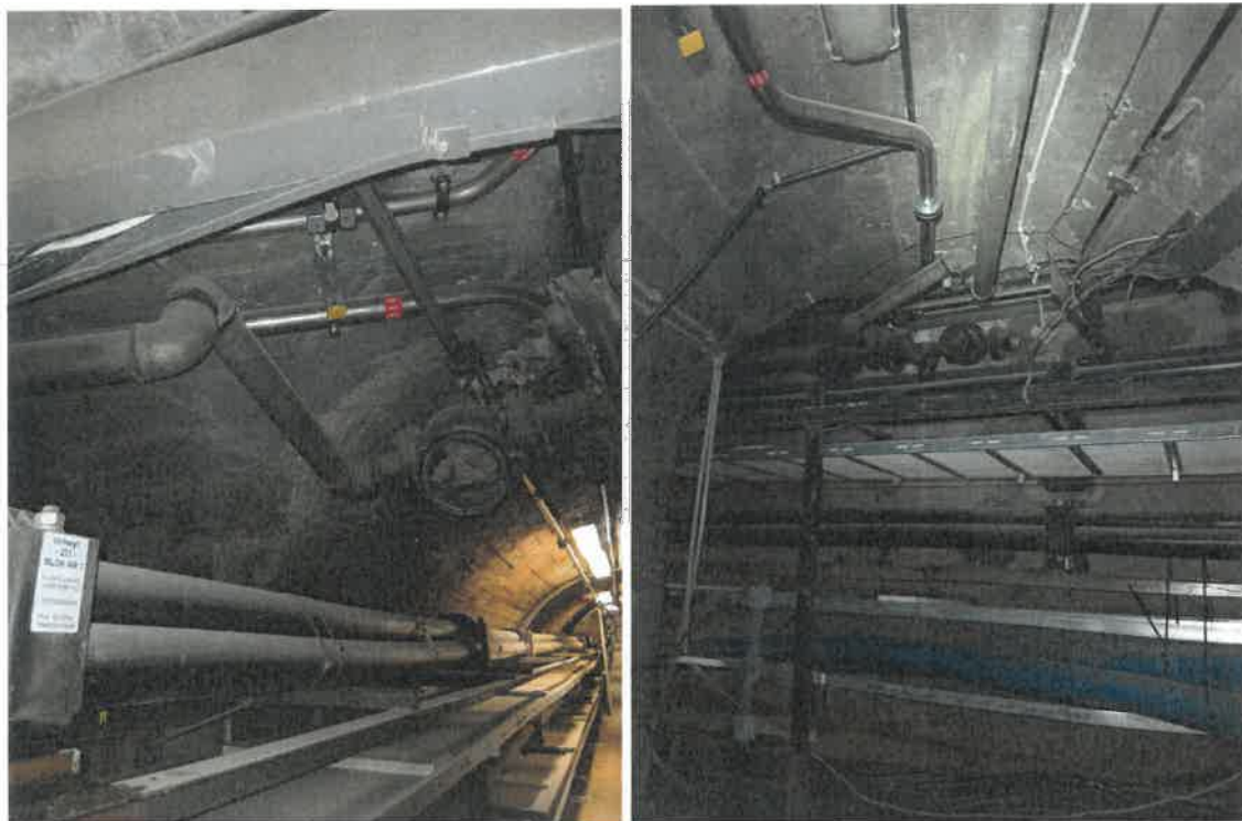
Zdjęcie 11,12. Miejsce zmiany kierunku prowadzenia instalacji wodociągowej na cele bytowe.
