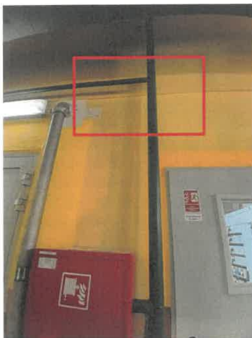
Zdjęcie 1. Istniejące odejście instalacji wodociągowej na cele bytowe.
