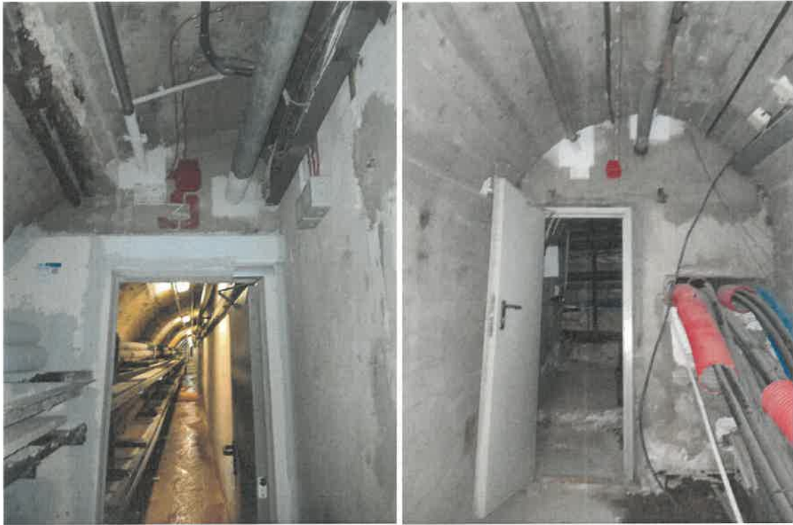
Zdjęcie 9,10. Sztolnia kablowa. Wybrane przejścia przez strefy pożarowe w celu zobrazowania sytuacyjnego.
